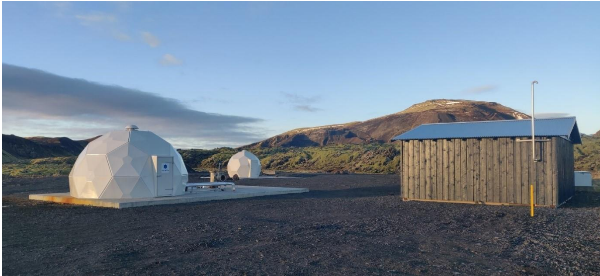
Mynd 6.3 Mannvirki niðurdælingarkerfis í Þrengslum. Fremra kúluhús hýsir holu HN-02.
